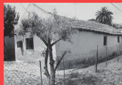
Techo de quincho terminado.
