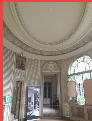
Sala oval del Museo donde se puede apreciar el trabajo en yeso ornamental del techo
