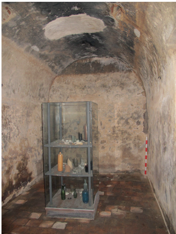
Figura 2. Vista del interior de la cisterna.
